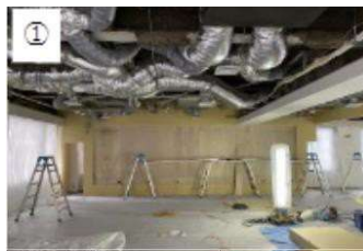
① 天井を抜き、執務室との壁を作ります
