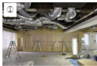
天井を抜き、執務室との壁を作ります
